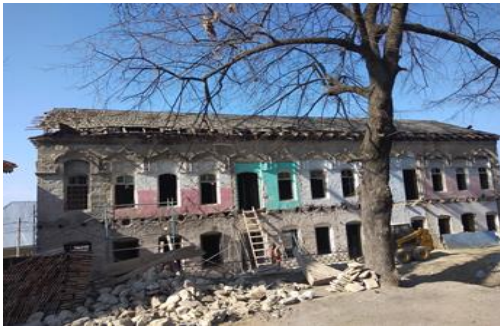
Şəkil 7. XIX əsrə aid bina.
