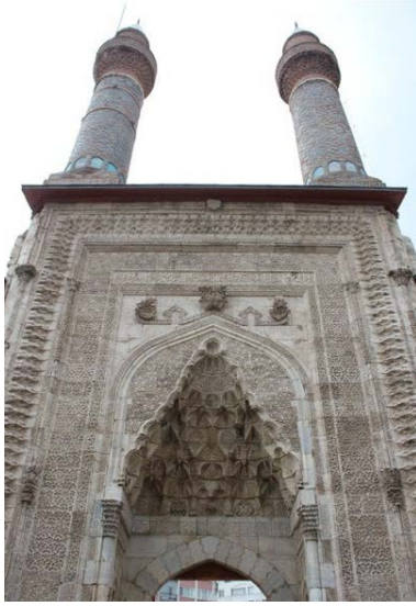
Resim 3: Çifte Minareli Medrese Taç Kapısı.
