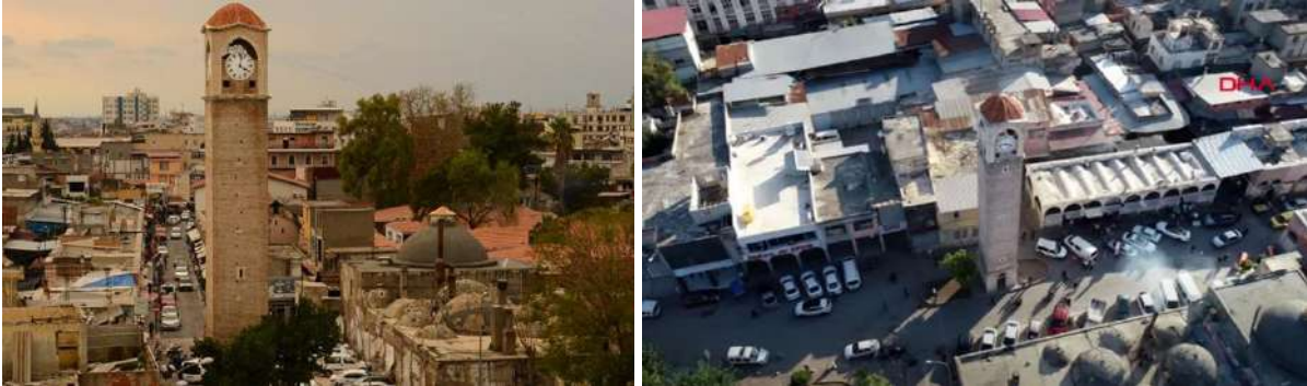
Resim 15, 16: Adana Saat Kulesi’nin günümüz durumu, Tarihi Dokudan Görünüm
