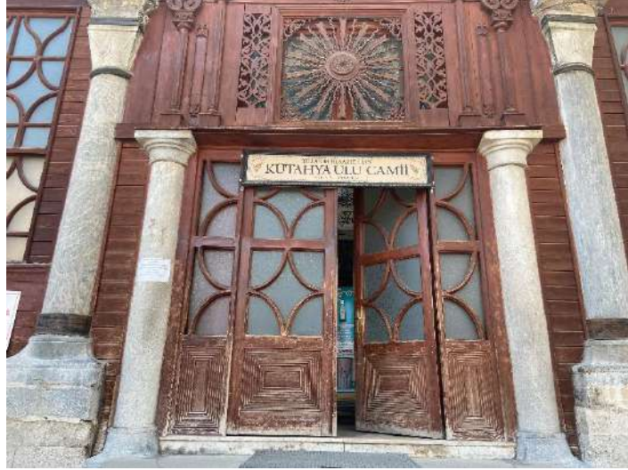
Görsel 4- Kütahya Ulu Camii girişi, Fotoğraf: Eren Evin Kılıçkaya
